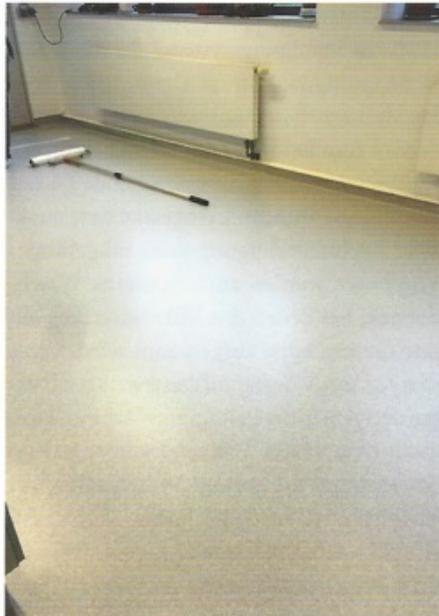
Fotos unten: Ein PVC-Bodenbelag in einer Teeküche (Verwaltung/Labor), welcher rund acht Jahre nicht mehr grundgereinigt worden war. Hier wurde eine alkalische Grundreinigung mit anschließender Beschichtung durchgeführt. Um auch Verkratzungen zu entfernen, wurde eine Polyacrylatbeschichtung mit hohem Festkörperanteil (Pemanentbeschichtung) eingesetzt.
